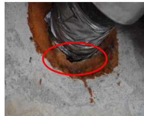
mangelhafte Rohrdurchführung
