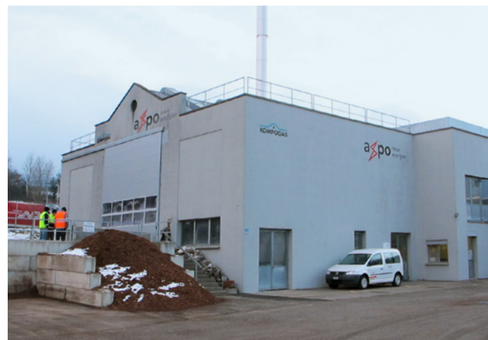
Die Kompogas-Anlagen der ersten Generation haben mit mehr als zwanzig Jahren ihren Zenith überschritten. An verschiedenen Standorten, so auch in Otelfingen (Bild), wird nach Ersatzlösungen ausserhalb von Industriezonen gesucht.
