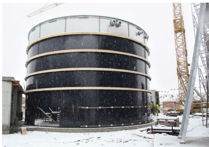
Die neue Abfallverordnung schreibt für flüssige Vergärungsprodukte eine Lagerkapazität von fünf Monaten vor. Dazu braucht es zusätzliche Lagerbehälter.
